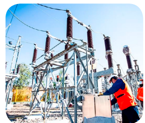
y los proyectos de enlace eléctricos
